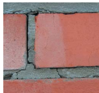
Zdjęcie 4. Zaprawa z plastyfikatorem jest krucha, łatwo pęka.
