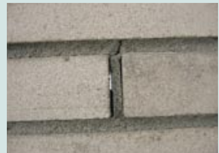
Zaprawa cementowa ze źle dobraną domieszką napowietrzającą charakteryzuje się osłabioną przyczepnością do cegły.
