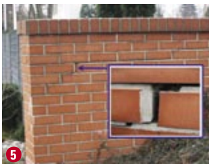
5 Utrata przyczepności zaprawy do cegły powoduje przyspieszoną degradację muru.
