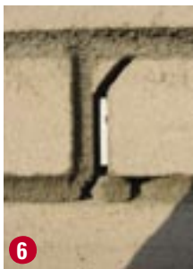
5 Utrata przyczepności zaprawy do cegły powoduje przyspieszoną degradację muru.
