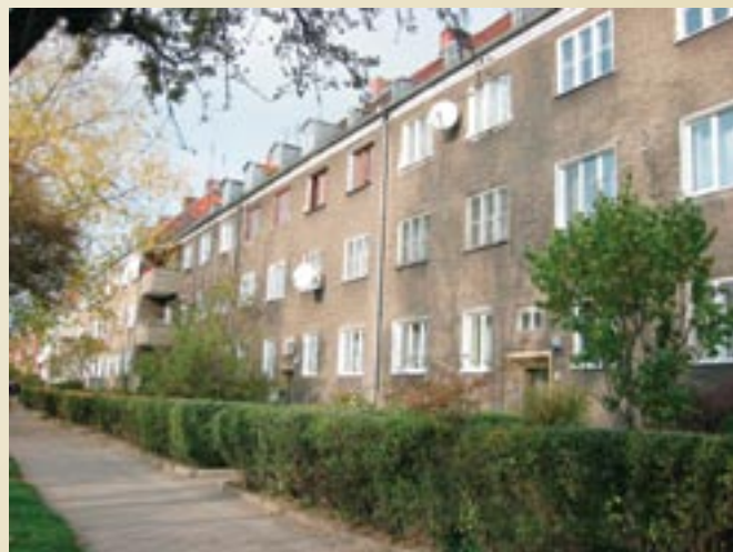
Fot. 5. Elewacja wykonana w tynku wapiennym (lata 30-te XX w.)
