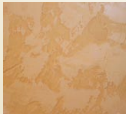
Fot. 3. Struktura uzyskana dzięki zastosowaniu gładzi wapiennej.
