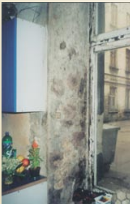
Fot. 2. Materiały podatne na zagryzienie szybko korodują biologicznie. Wygląd mieszkania w trzy miesiące po remoncie.
