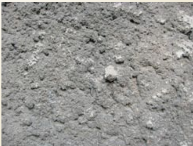
Fot. 4. Struktura 70-letniego tynku wapiennego. Brak widocznych uszkodzeń.
