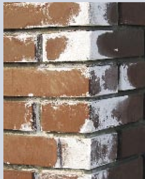
Białe wysolenia na cegle nie oznaczają, że jest to wapno hydratyzowane
