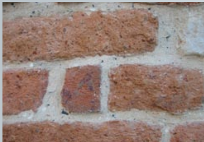
Fot. 1. Zaprawy z wapnem tworzą szczelną otulinę wokół cegieł. Fragment muru klasztoru w Tyńcu k.Krakowa.
