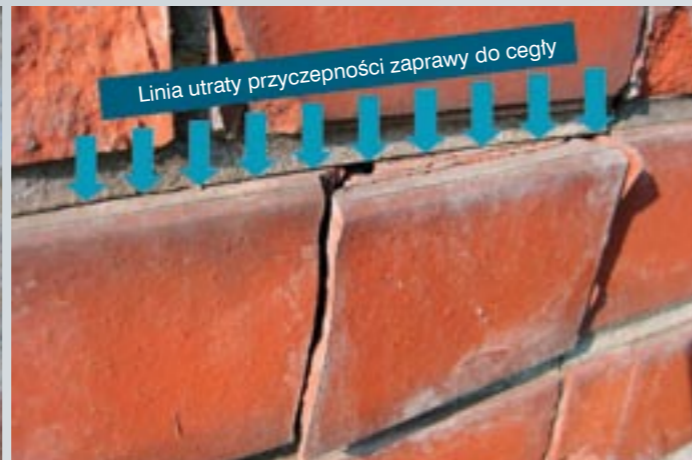
Fot. 2. Współczesne zaprawy pozbawione wapna są zbyt wytrzymałe do potrzeb. Ich mała przyczepność do cegieł obniża trwałość muru.
